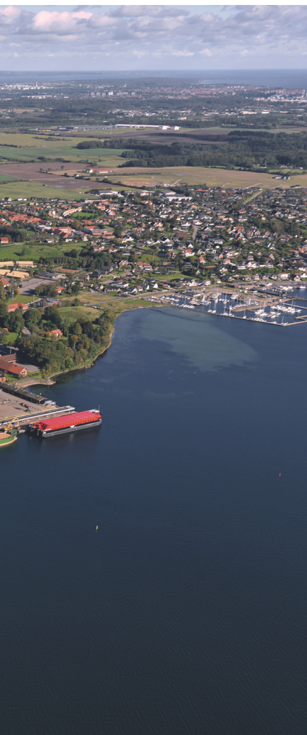
Skærbæk power station, Denmark
